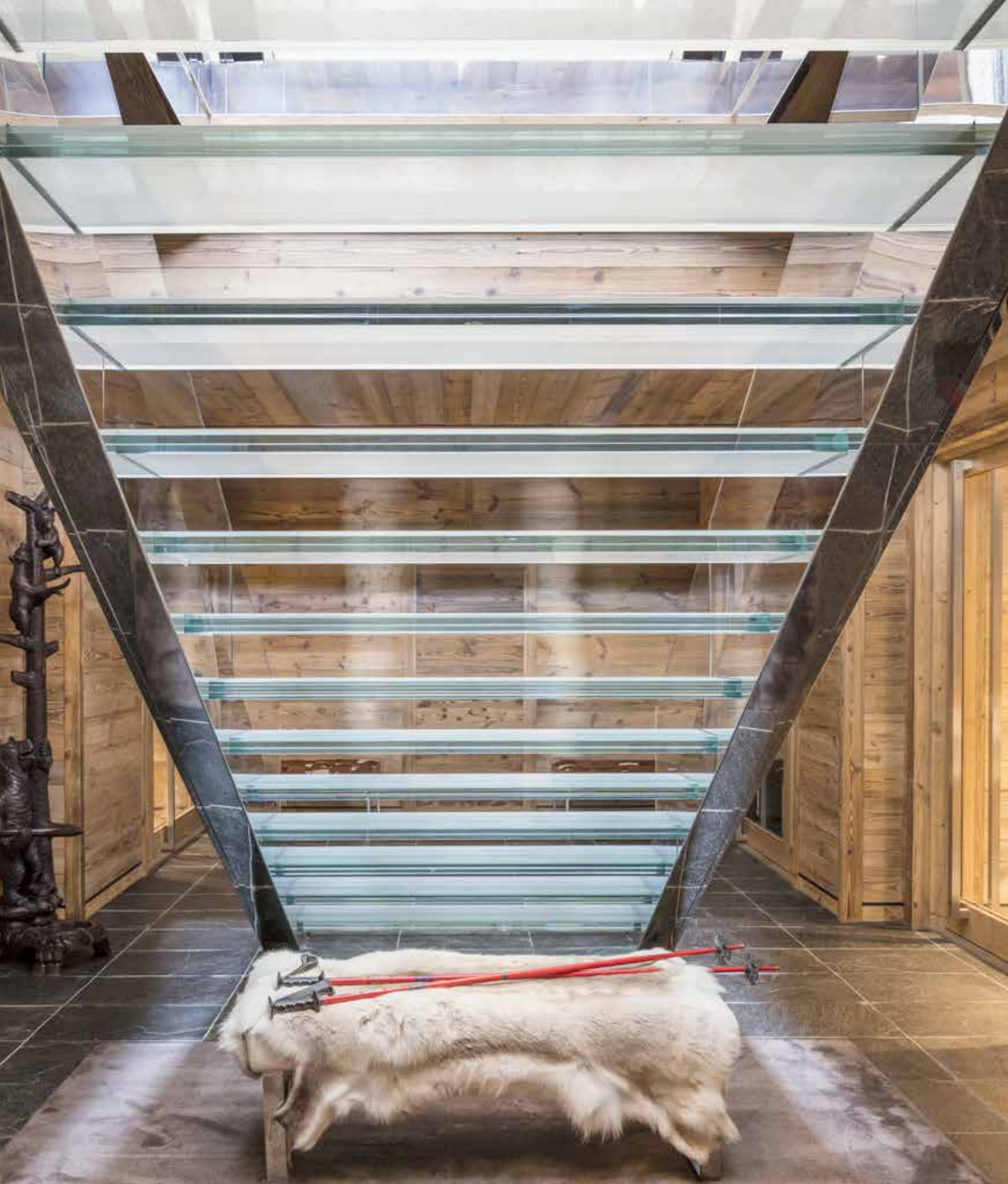
L'escalier en verre et poli-miroir plante le décor sur les trois étages. Ici, au sous-sol, il est associé à des matériaux naturels bruts comme le bois et l'ardoise clivée, et réchauffé de peaux de bête.
